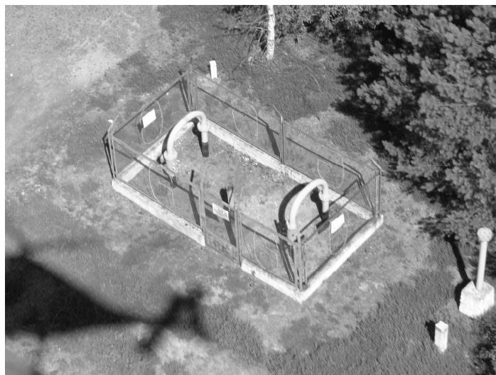
Rys. 1. Obiekt na trasie gazociągu. Fot. Źródło własne
