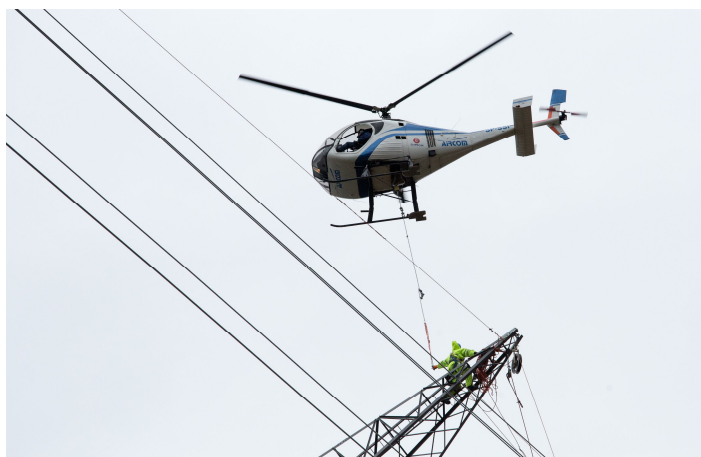
Rys. 2. Prace konstrukcyjne na linii 400 kV źródło Fot. ENPROM sp. z o.o.
